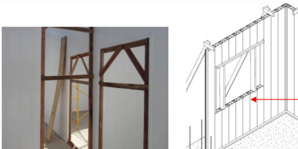
Figura 9 – Exemplo de escoramento de vãos de portas e janelas
