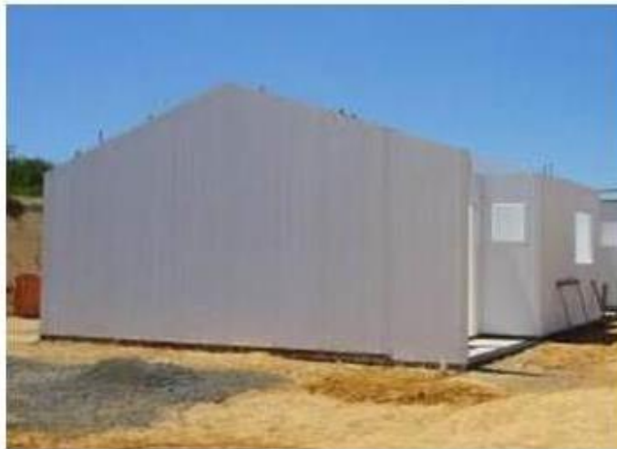
FIGURA 14 – Painéis de PVC concretados
