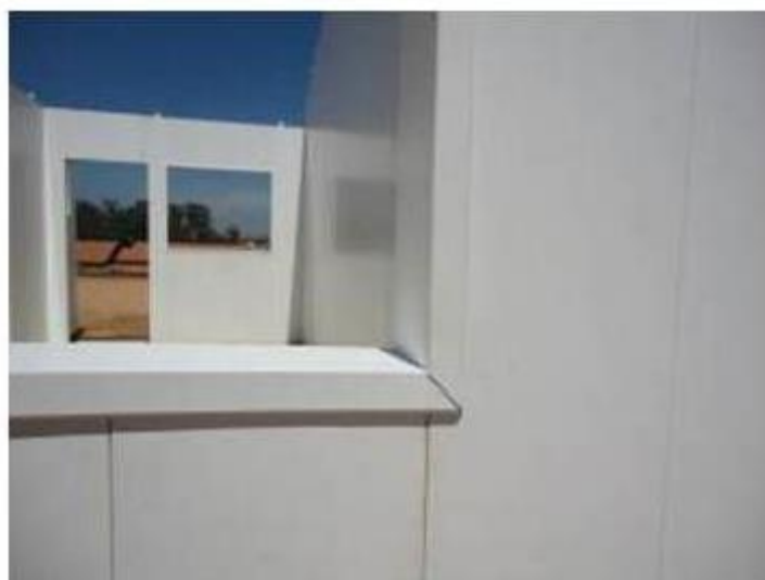
FIGURA 15 – Abertura das janelas com acabamentos em PVC
