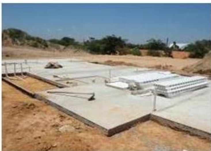
FIGURA 08 – Elemento de fundação com planicidade adequada
