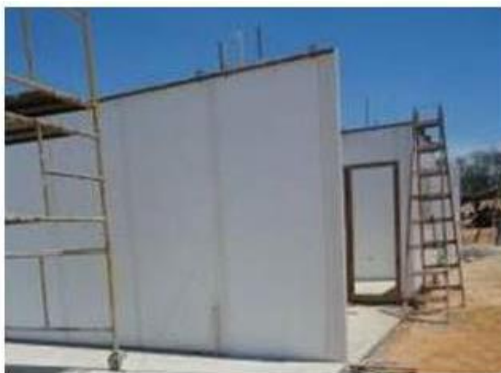
FIGURA 11 – Painéis de PVC posicionados e escorados
