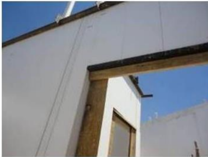
FIGURA 13 – Escoramento de aberturas de portas para concretagem
