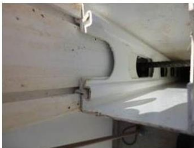
FIGURA 12 – Ferragem posicionada na região da contra-verga
