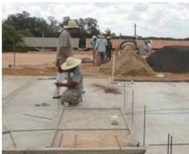
FIGURA 09 – Fixação das barras de ancoragem à fundação com adesivo epóxi
